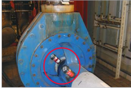
Lubrification de l'arbre moteur d'une pompe
