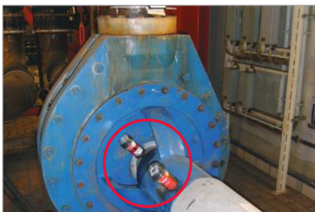
Lubrification de l'arbre moteur d'une pompe
