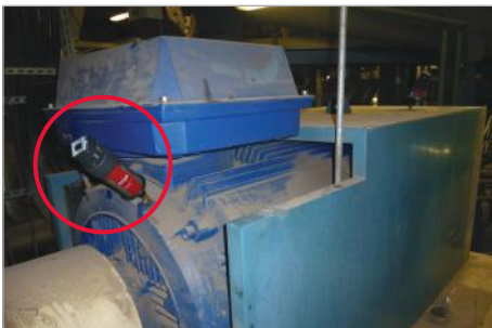
Lubrification d'un moteur de pompe
